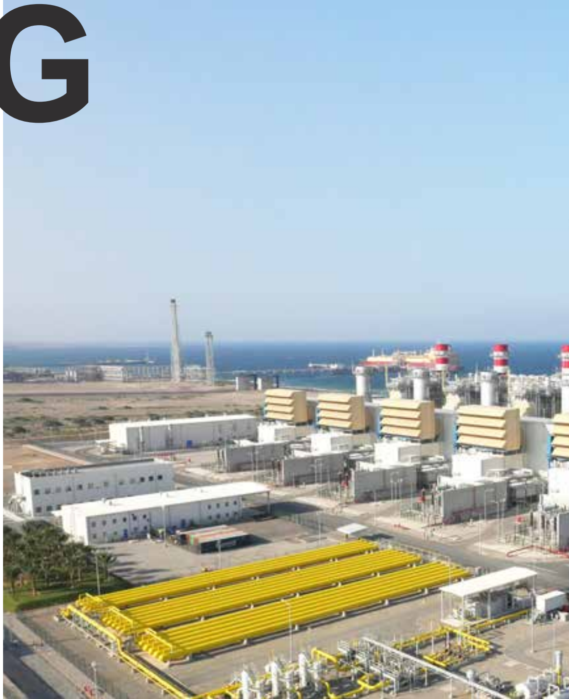
오만 LNG 복합화력 발전소
